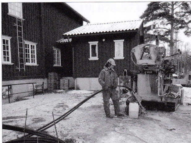
Martin Olsson matar ner de sista metrarna av värmeslangen i borrhålet.
